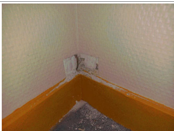
Prélèvement - 15 : INT / R+2 / Plateau de bureaux - Enduit de jointoiment de plaques de plâtre- (Absence d'amiante)
