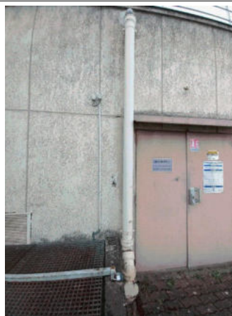
Déclaré - : EXT / Façades / RDC (au niveau du Local Transformateur) - Conduit- (Absence d'amiante)
