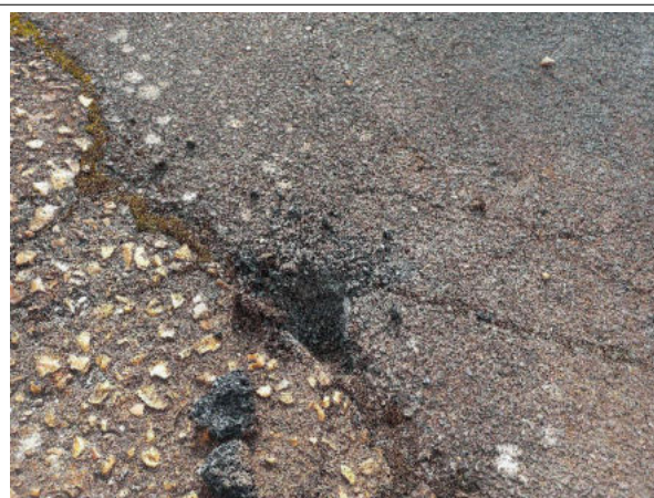
Prélèvement - 36 : EXT / Voirie / Zone arrière - Enrobé bitumineux- (Absence d'amiante)
