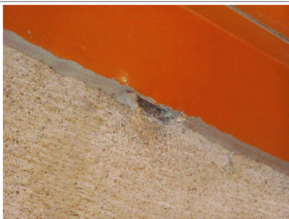
Prélèvement - 21 : EXT / Façades / R+2 (au niveau du plateau de bureau) - Joint- (Absence d'amiante)
