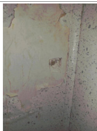
Prélèvement - 16 : INT / R+2 / Plateau de bureaux - Enduit- (Absence d'amiante)
