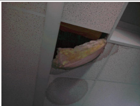
Prélèvement - 7 : INT / R+2 / Plateau de bureaux - Faux plafond- (Absence d'amiante)
