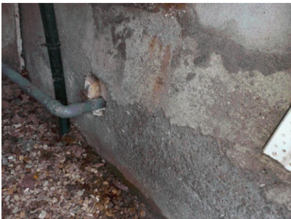
Prélèvement - 40 : EXT / Façades / Zone Groupe froid - Enduit- (Absence d'amiante)
