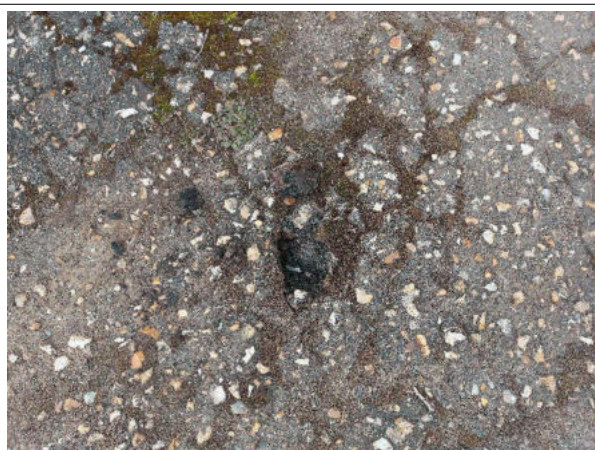
Prélèvement - 35 : EXT / Voirie / Zone arrière - Enrobé bitumineux- (Absence d'amiante)
