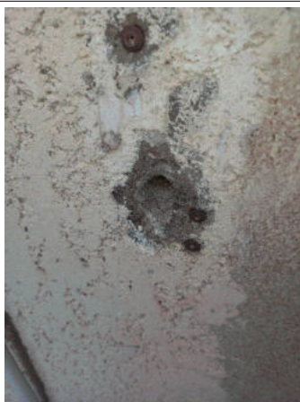
Prélèvement - 33 : EXT / Façades / RDC (au niveau du Local Transformateur) - Crépis- (Absence d'amiante)
