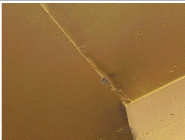
Prélèvement - 29 : INT / RDC / Local Transformateur - Enduit- (Absence d'amiante)
