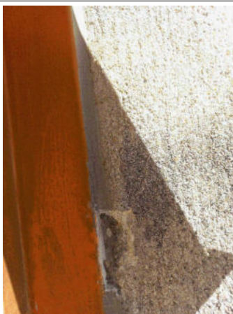
Prélèvement - 19 : EXT / Façades / R+2 (au niveau du plateau de bureau) - Joint- (Absence d'amiante)
