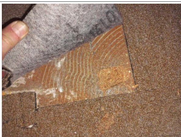
Prélèvement - 9 : INT / R+2 / Plateau de bureaux - Colle- (Absence d'amiante)
