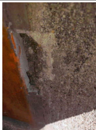
Prélèvement - 20 : EXT / Façades / R+2 (au niveau du plateau de bureau) - Crépis- (Absence d'amiante)
