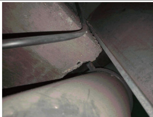
Prélèvement - 26 : INT / R+2 / Plateau de bureaux - Enduit- (Absence d'amiante)
